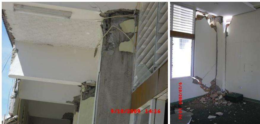
**Gambar 36.** Pola Kerusakan tipikal joint pada kolom-balok
