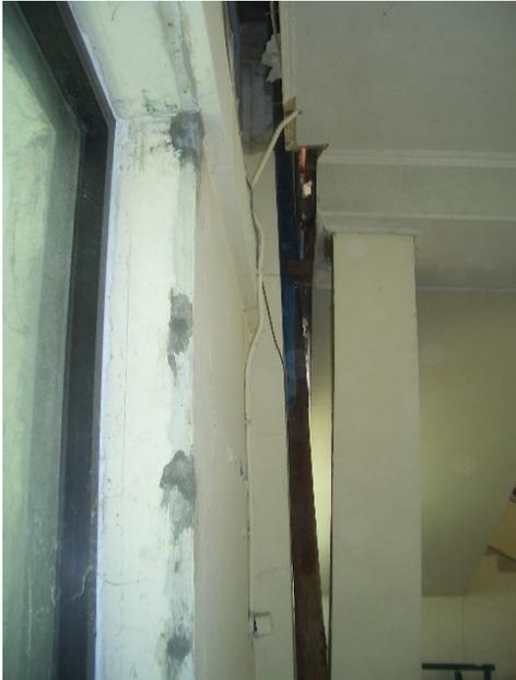
**Gambar 58.** Kolom luar yang memikul rangka atap bergeser, kolom dalam masih tegak
