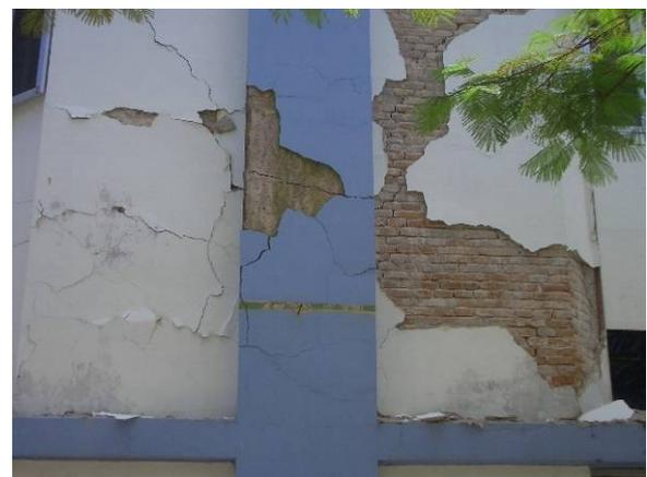
**Gambar 60.** Kolom masih tegak tetapi terdapat retakan pada kolom, perlu diperkuat
